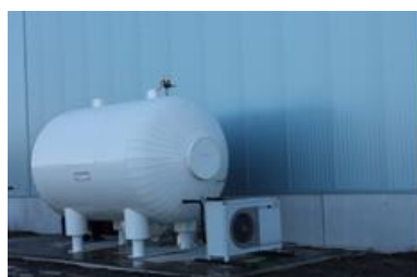
Figuur 5.6 a en b – LPCO 2 - en een CO 2 -blusgassysteem t.b.v PGS 15-opslag
