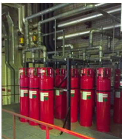
Figuur 5.7 – Opstelling chemischblusgassysteem t.b.v. groot compartiment
