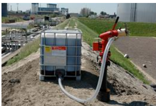
Figuur 5.8 b – Voorbeeld van een automatisch oscilerende monitor met schuimconcentraatbijmenging, zonder IBC-reservoir
